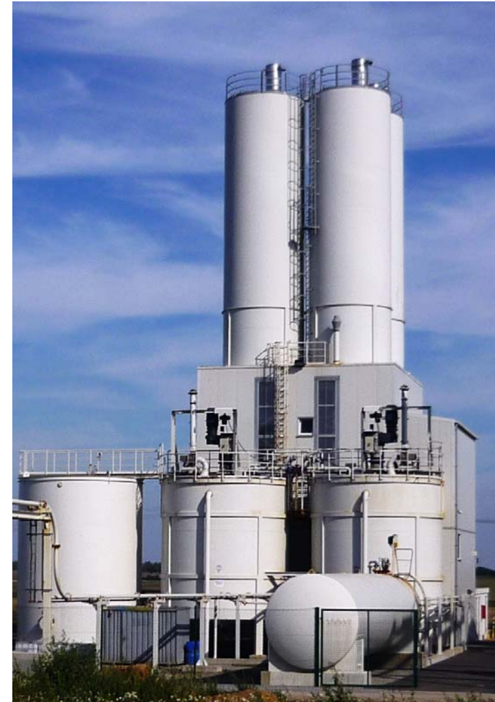
Dickstoffversatzanlage Triftweg · 39418 Staßfurt
